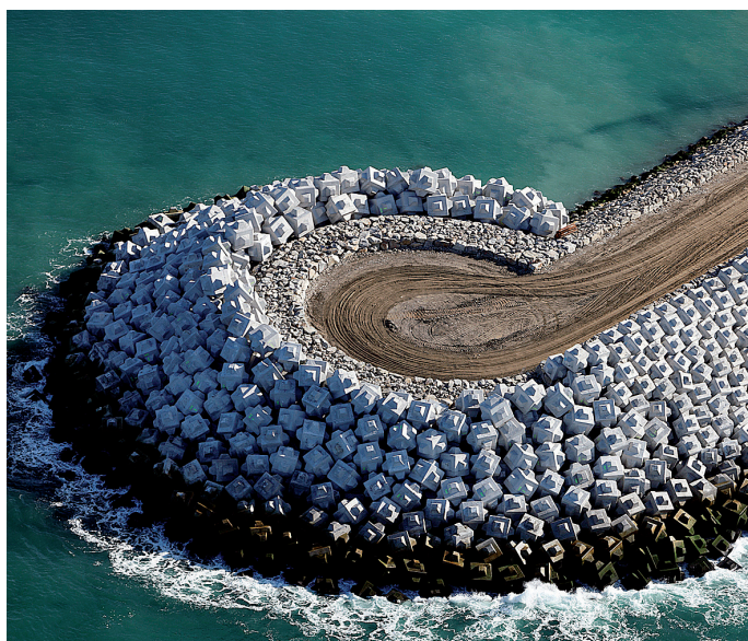
Dique Oeste. Punta Langosteira. La Coruña. Galicia.
